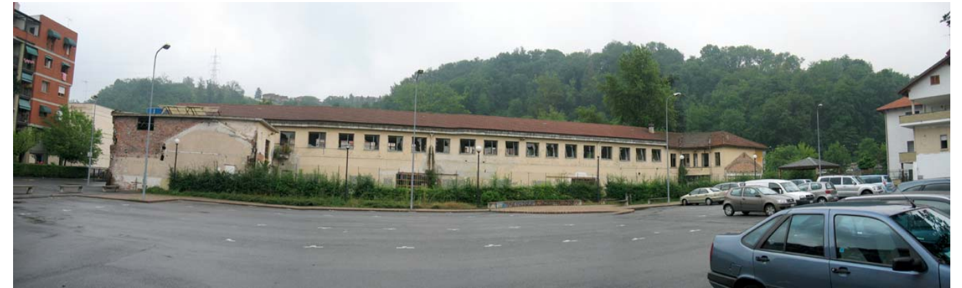
3. Vista degli ex fabbricati industriali Desalles-Borzino e del piazzale da v. XXV Aprile
