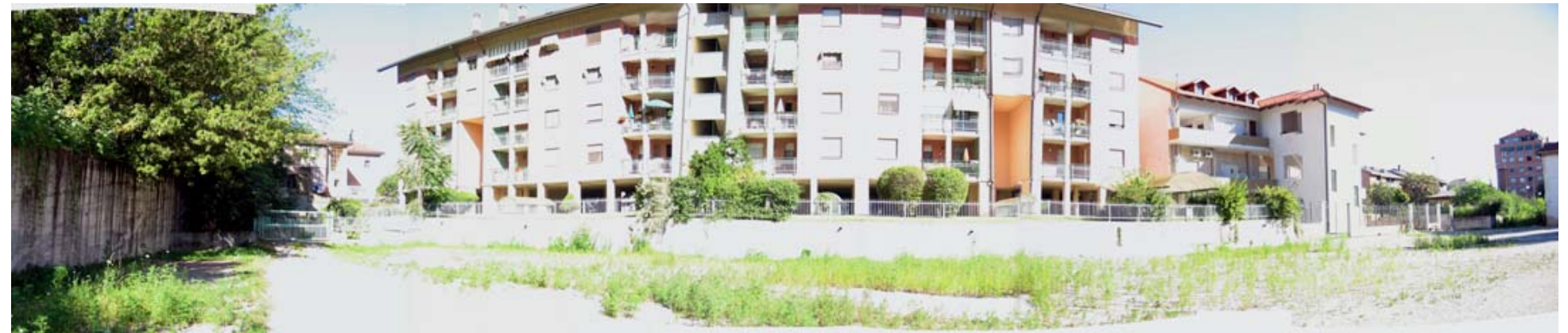
5. Vista del piazzale sud-est verso la S.P. Torino-Casale e dei prospicienti fabbricati residenziali
