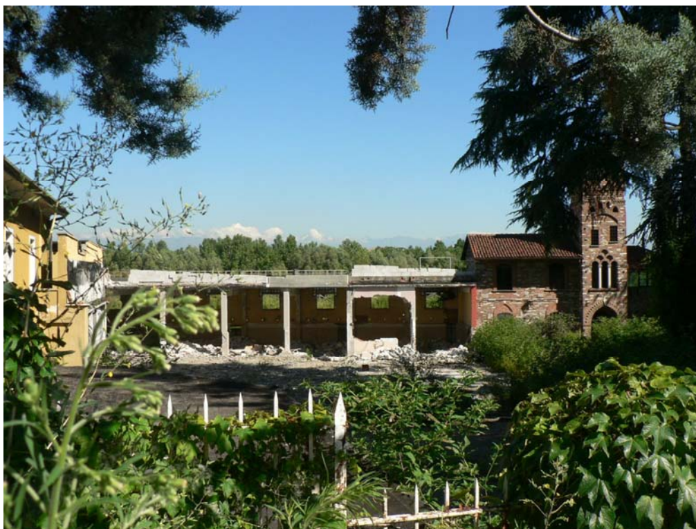
Figura 1/6 Gli edifici produttivi abbandonati ed il “Castelletto” visti dalla recinzione su via Torino
