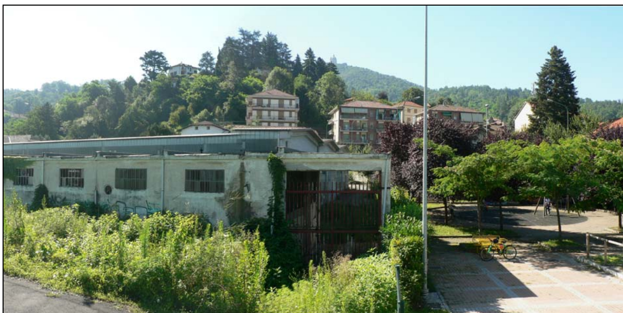
Figura 1/3 Vista dallo spigolo nord ovest dell'area RU.C2. Edifici abbandonati adiacenti all'area gioco bimbi. Sono visibili i condomini oltre via Torino, sulle pendici della collina. Sullo sfondo la Basilica di Superga
