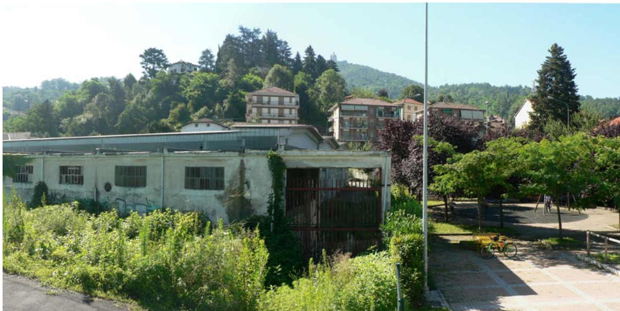
Foto 6 – Spigolo nord ovest dell'area RU.C2. Edifici abbandonati adiacenti all'area gioco bimbi. Sono visibili i condomini oltre via Torino, sulle pendici della collina. Sullo sfondo la Basilica di Superga
